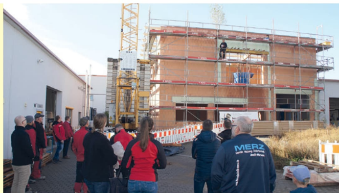
Zimmerer-Meister Hans Feser auf dem Gerüst. Voraussichtliche Fertigstellung des Wärmepumpen-Kompetenzzentrums ist 3/2023
